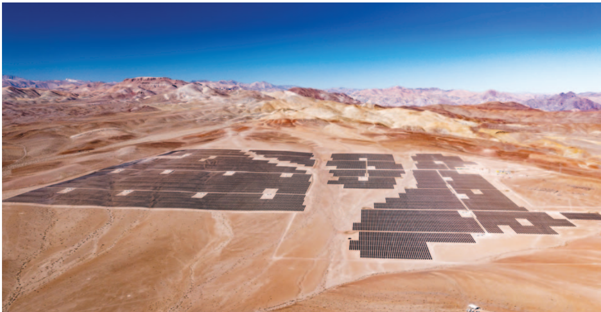
145 MW Rio Escondido solar park, Tierra Amarilla, Atacama, Chile.
